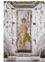
LaRes.II, Venuszimmer, Gewölbe, Südseite, R.20, DI005361, BSV
